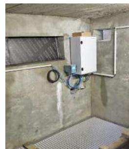
Emplacement du coffret 2 et du transmetteur dans le local captage
