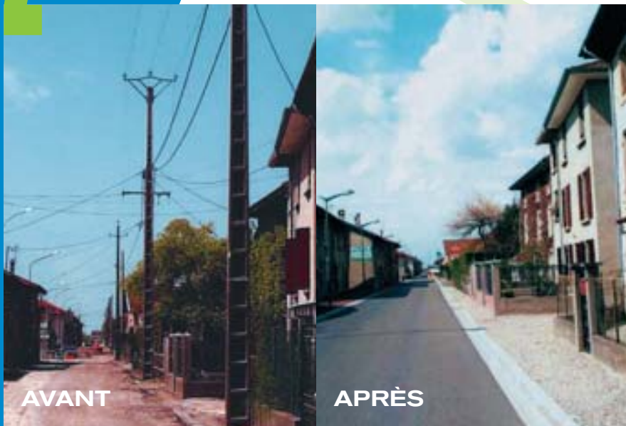
Enfouissement des lignes à Sillans (38)
