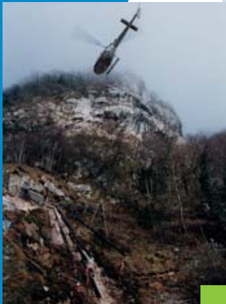
Pose d'une conduite d'eau potable par hélicoptère, Saint-Paul-de-Varces (38)
