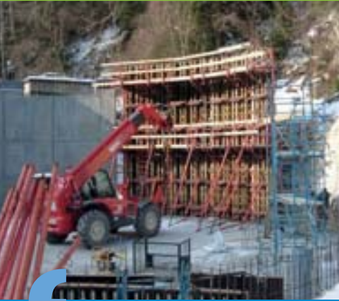
Construction d'un réservoir de 2 000 m 3 pour le Pays Voironnais
