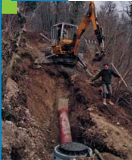
Pose d'un collecteur d'eaux usées en terrain accidenté
