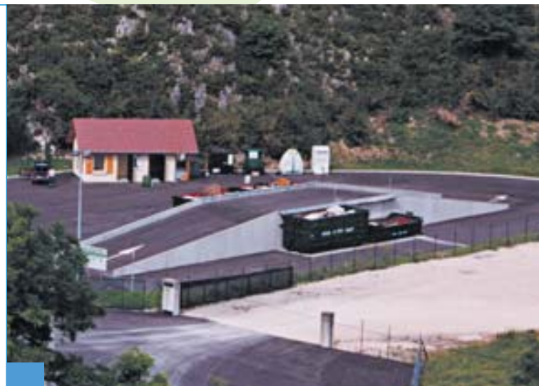
Déchetterie de Virieu-le-Grand
