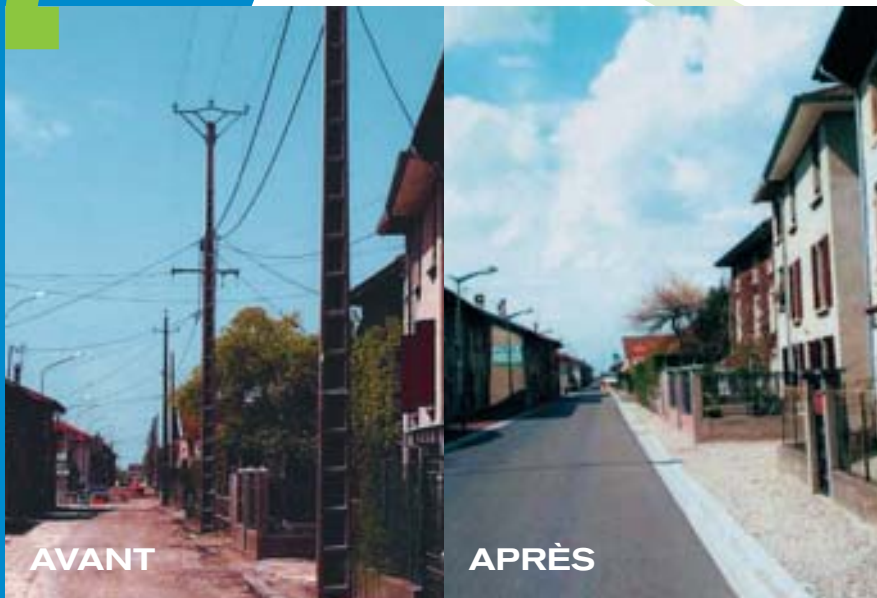
Enfouissement des lignes à Sillans (38)
