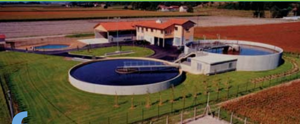
Station d'épuration de Beaurepaire (38)
