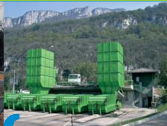
Quai de transfert des déchets ménagers au site écologique de La Buisse (38) (Pays Voironnais)
